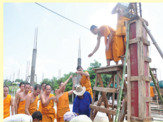
งานก่อสร้าง
