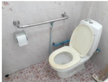
ที่พักอาศัย ห้องน้ำมีราวจับ เหมาะสำหรับผู้สูงอายุ
